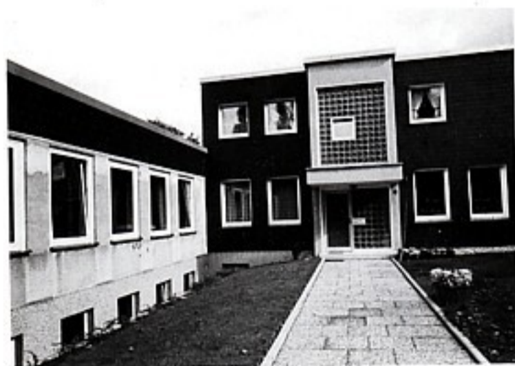
Im Zuge der Erweiterung des Pfarrheimes entstand u.a. eine moderne Hausmeisterwohnung
